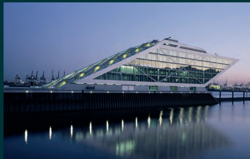
Dockland Bürogebäude Hamburg, 2006
